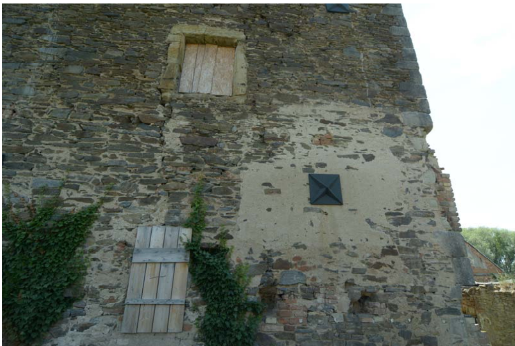
Pozůstatky omítky na severní fasádě, stažení objektu ocelovými táhly.
