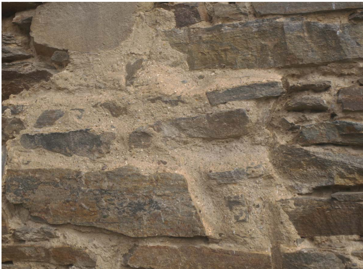
Vzorek omítky na jižní straně fasády – tento bude sloužit jako vzor struktury, barevnosti i způsobu spárování
