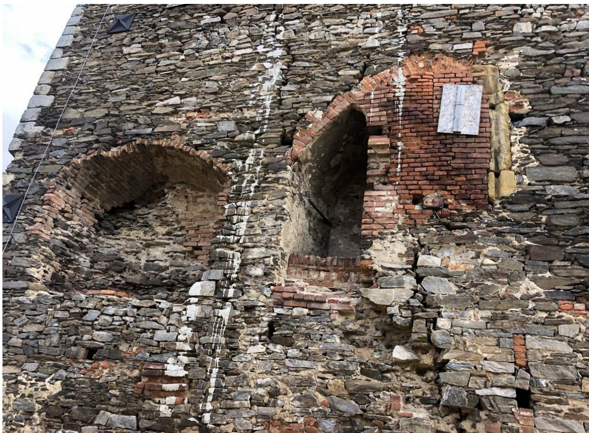
Vlevo výklenek s poničeným cihelným ostěním, vpravo stávající podoba vstupu do 2NP
