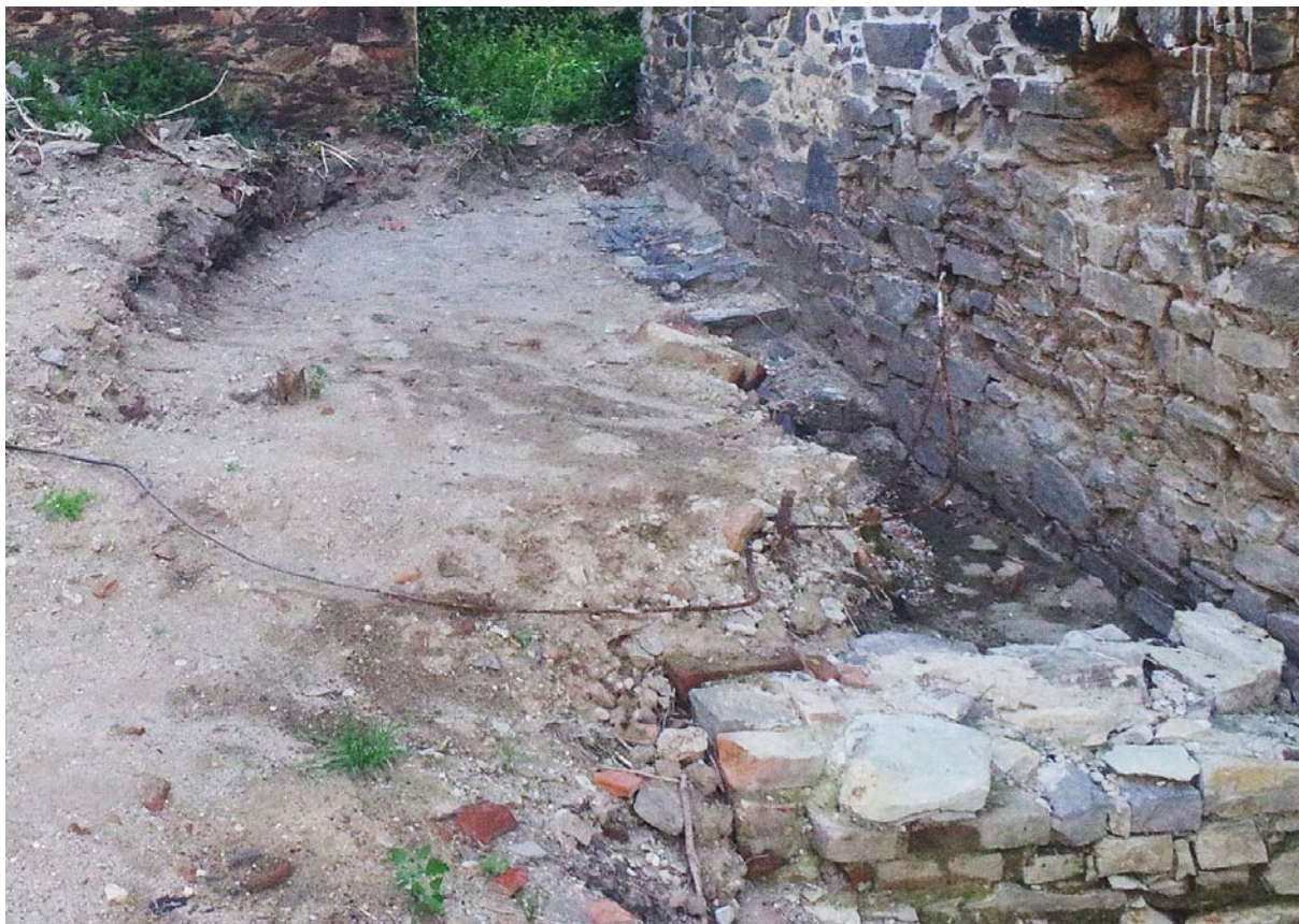
Fotografie sondy původní kamenné dlažby dvora, v popředí patrný základ přístavku schodiště z 20.stol. Foto IHARCH/ 2022.
