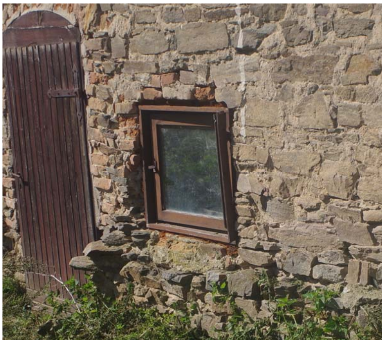
Sokl objektu na východní fasádě vyčnívá, dokládá zbytky pro navázání jiného objektu. Okno, dveře a ostění budou upraveny.
